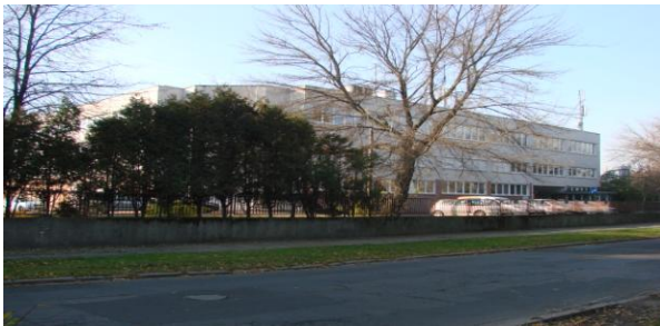
Widok budynku biurowego od strony al. Stanów Zjednoczonych
